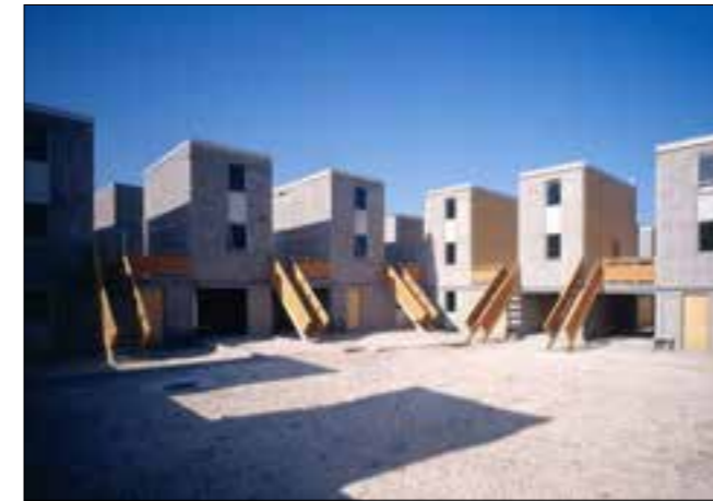
Zustand nach Fertigstellung
