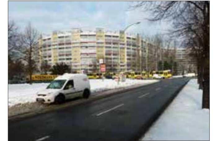
Platz der Vereinten Nationen (Atelier-Dachwohnungen)
