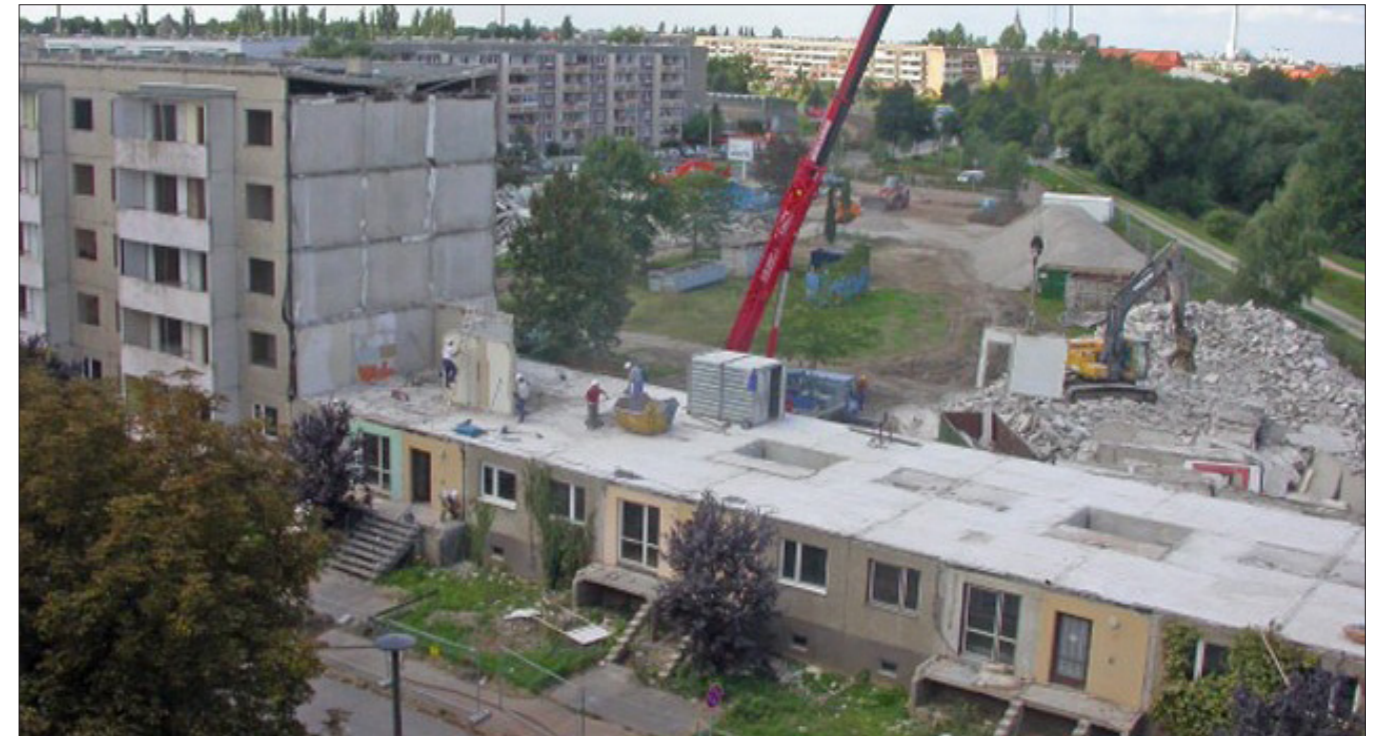
Rückbau der Plattenbauten
