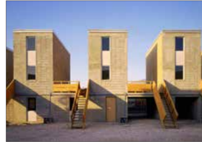
Zustand nach Fertigstellung
