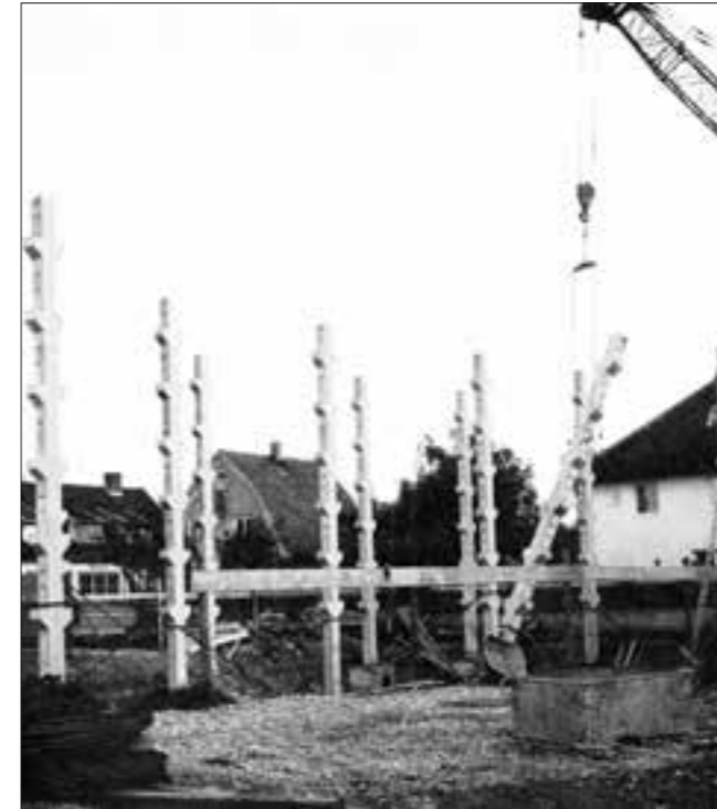
Montage der Fertigteilkonstruktion
