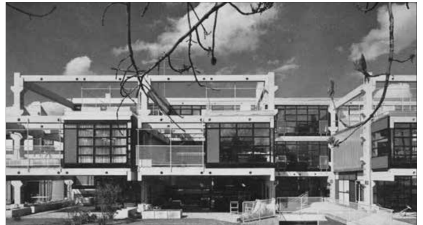
Zustand nach Einbau der Wohnungen
