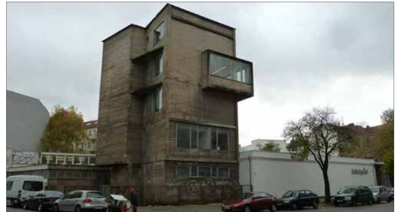
Ansicht von der Straßenseite mit markantem Eckgebäude
