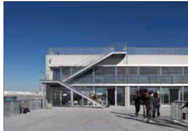
Zugang zum Dach
