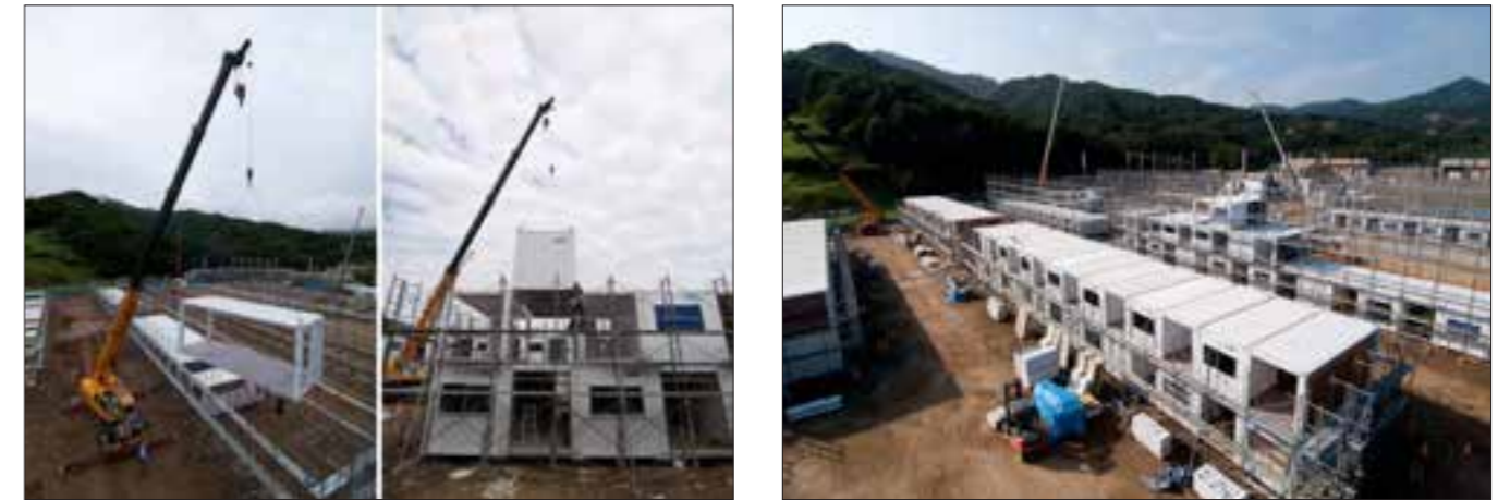
Montage der Container
