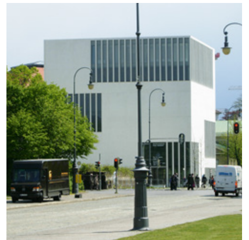
Das NS-Dokumentationszentrum von Südwesten am Tag der Eröffnung, 1. Mai 2015, Foto: Stefanie Endlich
